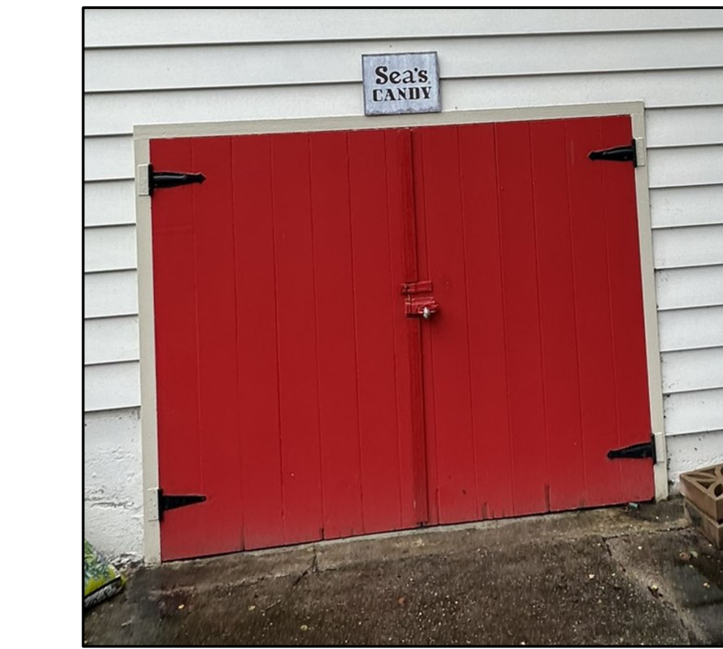
EXISTING GARAGE DOOR
