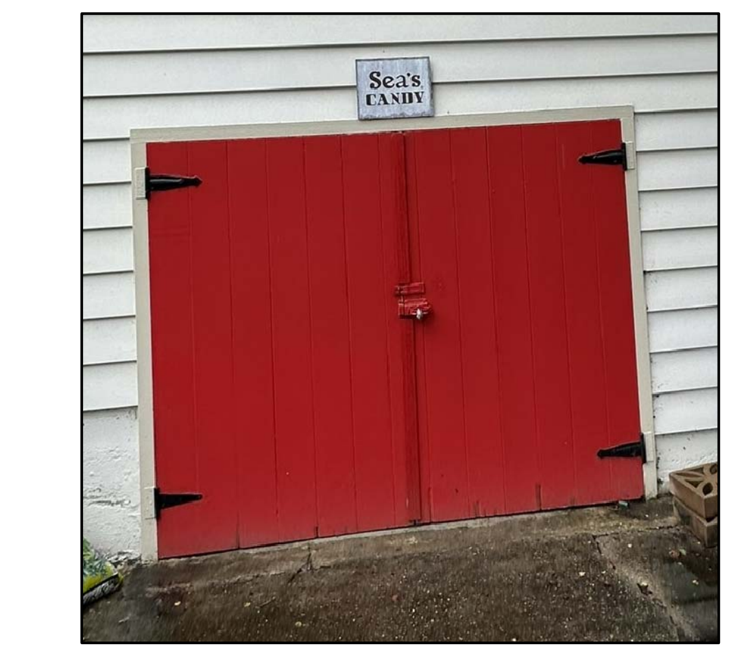
EXISTING GARAGE DOOR
